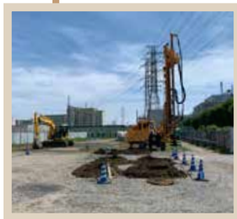
支柱工事風景
